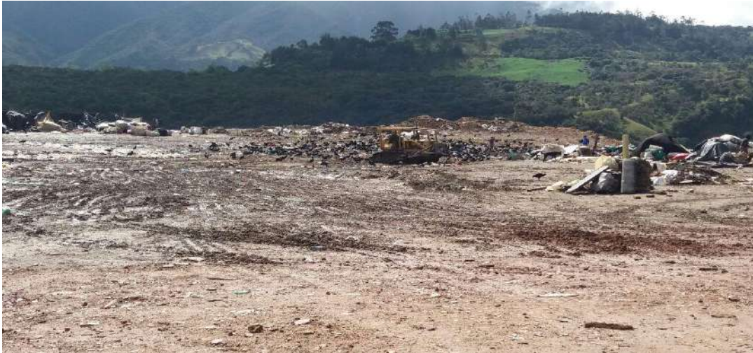
Foto 8: Cubrimiento Residuos Sólidos Relleno Sanitario.
