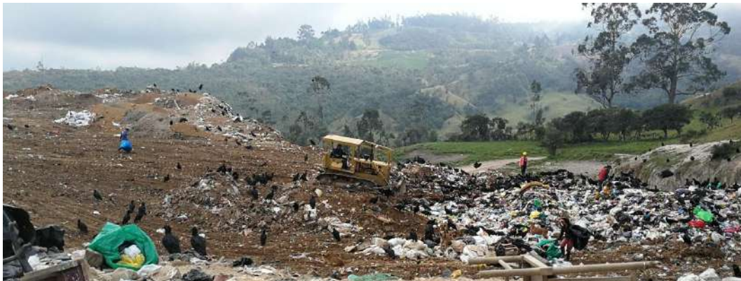
Foto 9: Cubrimiento Residuos Sólidos Relleno Sanitario.
