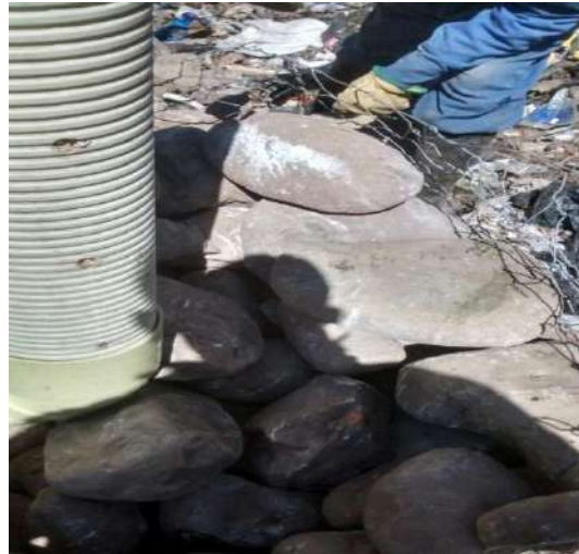
Foto 6: Mantenimiento de Filtros Perimetrales.
