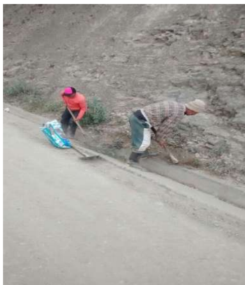
Foto 3: Mantenimiento cunetas de agua lluvia.
