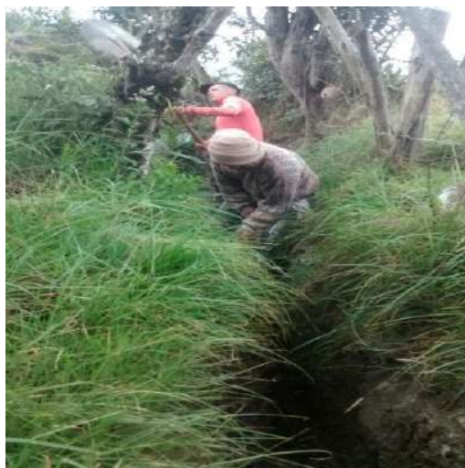
Foto 5: Mantenimiento cunetas de agua lluvia.
